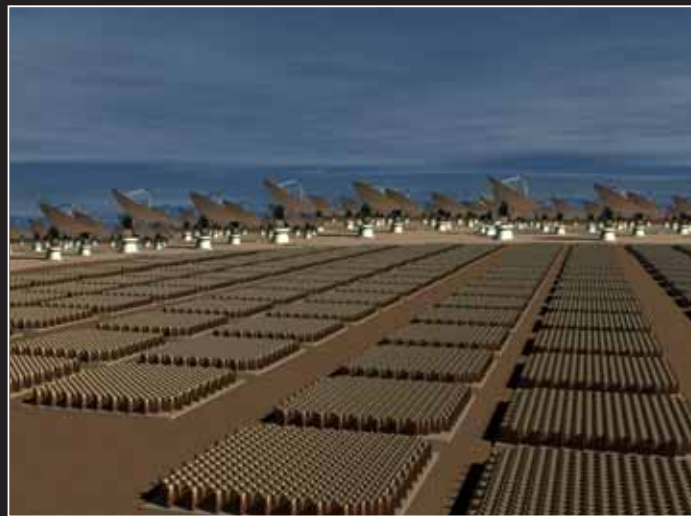
Simulación de un posible diseño para el núcleo central del "Square Kilometer Array", combinando antenas planas impresas y pequeños paraboloides.
